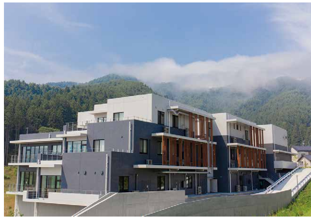
5-9 再建された新しい研究棟
