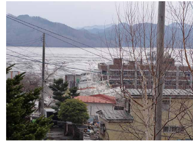
5-3 東北地方太平洋沖地震に伴う津波の襲来（2011年3月11日） 12.2mの大津波によって、センターも3階の窓付近まで水没しました。
