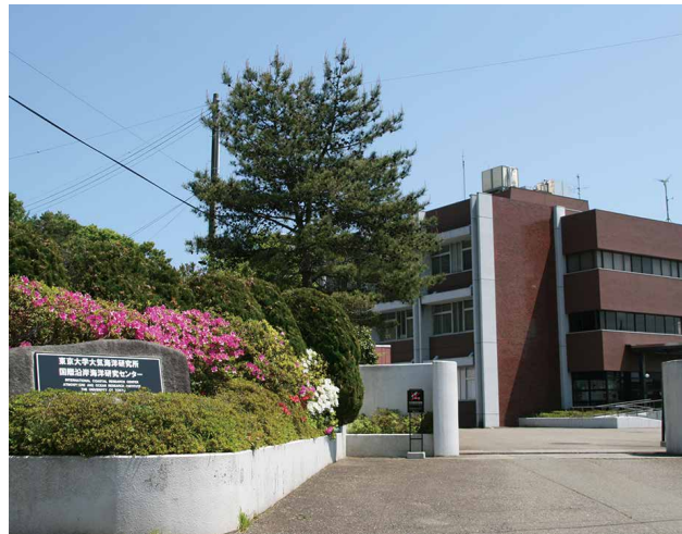
5-1 国際沿岸海洋研究センターの旧研究棟
