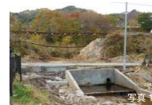
織笠駅から岩手船越駅間の三陸鉄道の線路被害（2019.11.15撮影） 大雨により、路盤が流出してレールが宙吊りに。山から流れ出る水を排水しきれませんでした。
