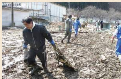
2011年3月25日 釜石工場前 工場再稼働を6月14日と定めスタートした頃
