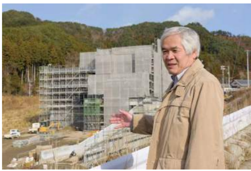
赤浜地区の高台に建設中の国際沿岸海洋研究センター 写真は2017年12月撮影。本年3月に現在の場所から移転し、新オープン予定している
