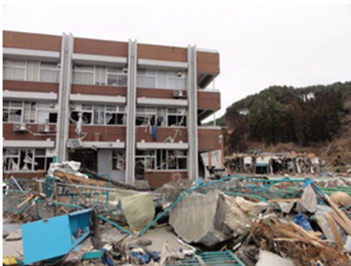
図 1-1 2011年3月11日の大津波により壊滅的な被害を受けた沿岸センター。辛うじて被害を免れた3階の一部をリフォームし、2018年に新研究棟が高台に建設されるまでの間、本大課題の調査研究の足場として利用した。
